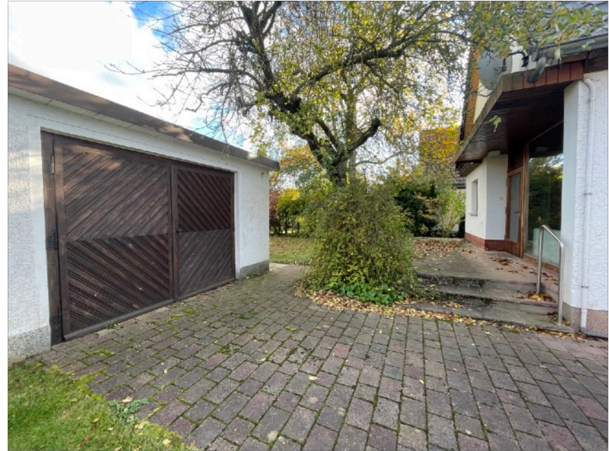
Massive Einzelgarage mit Zugang zum hinteren Garten
