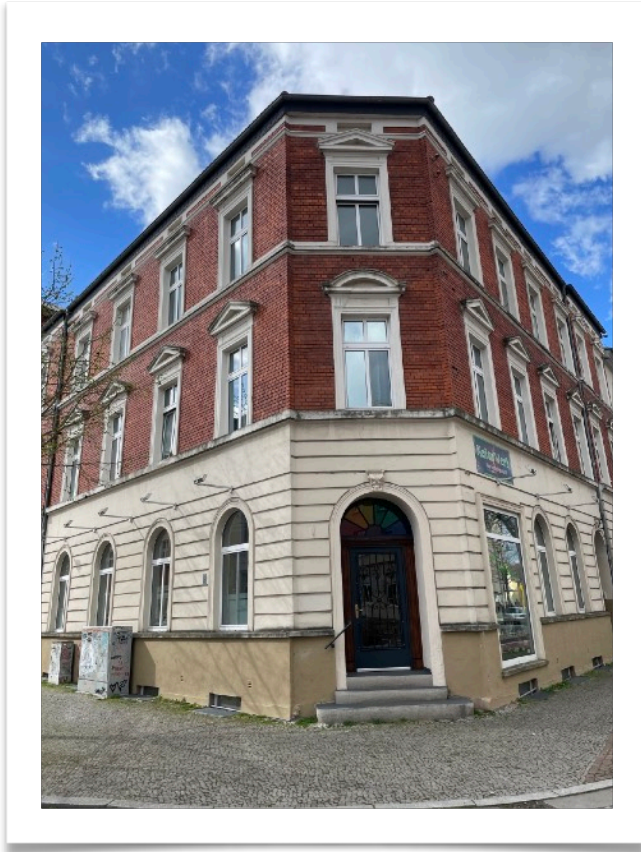
Straßenansicht mit Eingang Gewerbeeinheit
